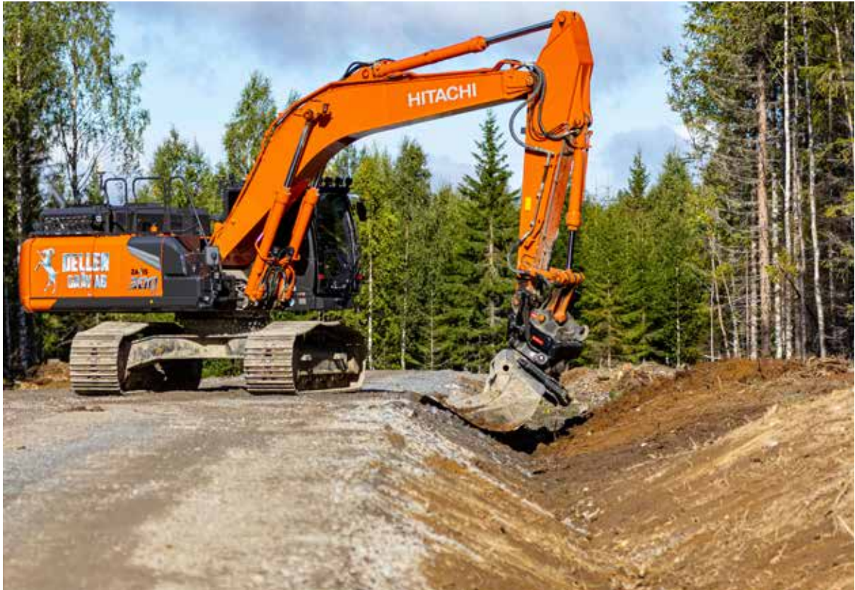
Figur 9. Exempel på nyanläggning av väg inom Klevberget vindpark i Ånge kommun (foto: OX2).
