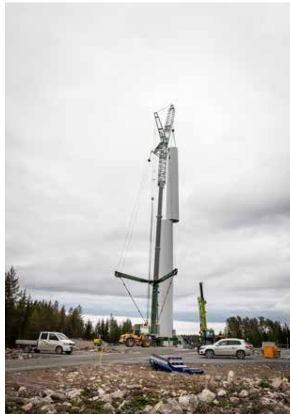
Figur 7. Resning av verk inom Vindpark Valhalla i Bollnäs- och Ockelbo kommuner (foto: Joakim Lagercrantz).
