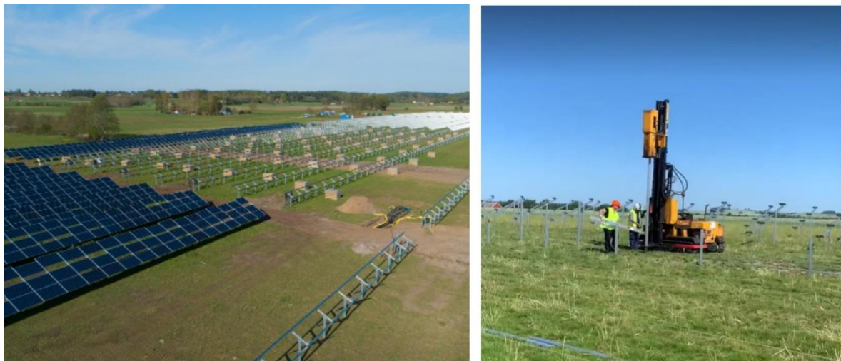
Figur 5 och 6. Vänster: exempel på montage av solpaneler på markställningar. Anläggningen är Svea Solars solpark i Sjöbo (Bildkälla: Ny Teknik). Höger: Pålning av balkar med pålningsmaskin (foto: Magnus Fast, OX2).
