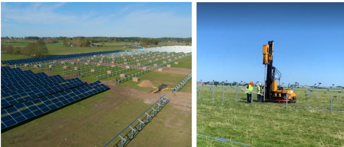
Figur 11. Vänster: exempel på montage av solpaneler på markställningar. Anläggningen är Svea Solars solcellspark i Sjöbo (Bildkälla: Ny Teknik). Höger: Pålning av balkar med pålningsmaskin (foto: Magnus Fast, OX2).
