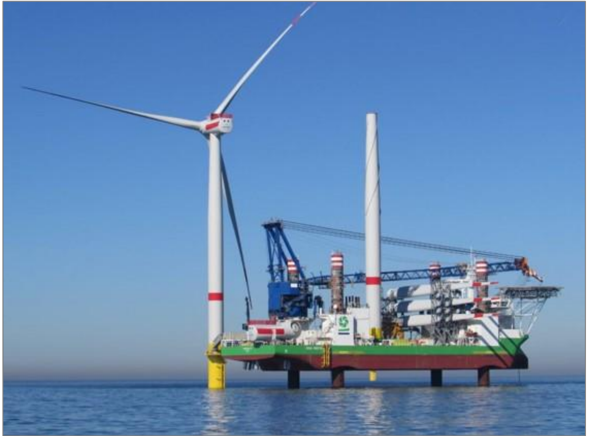
Kuva 1-11. Merituulivoimalan asennus jack-up aluksella (kuva: COWI).
